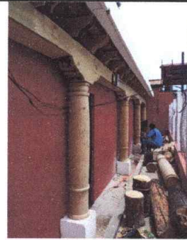
Foto 4: Instalación de Columnas Torneadas
