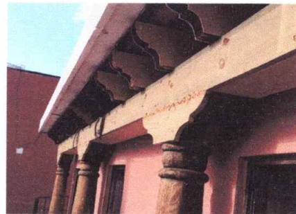
Foto 6: Remozamiento de Techo
