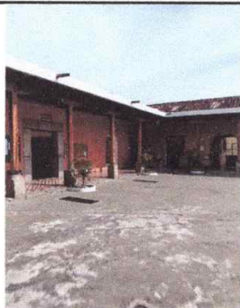
Foto 3: Paredes de Patio Principal Pintadas
