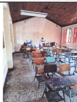
Foto 2: Salón de Clases en trabajos de pintura
