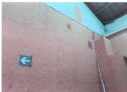
Foto 3: Pared area básico en trabajos de pintura
