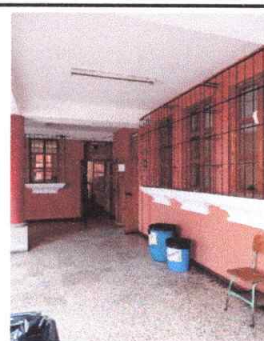
Foto 4: Pasillo de Diversificado limpio y Pintado.
