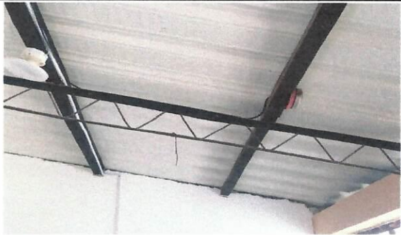
ESTRUCTURA DE MADERA DEL TECHO
