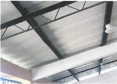
ESTRUCTURA ORIGINAL DEL TECHO .
