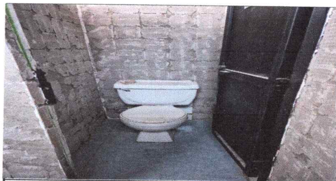
Foto 12: DEMOLICION TOTAL DE BAÑOS DE NIÑAS
