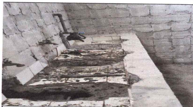
Foto 10: DEMOLICION TOTAL DE LAVAMANOS
