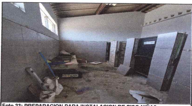
Foto 23: PREPARACION PARA INSTALACION DE PISO NIÑAS
