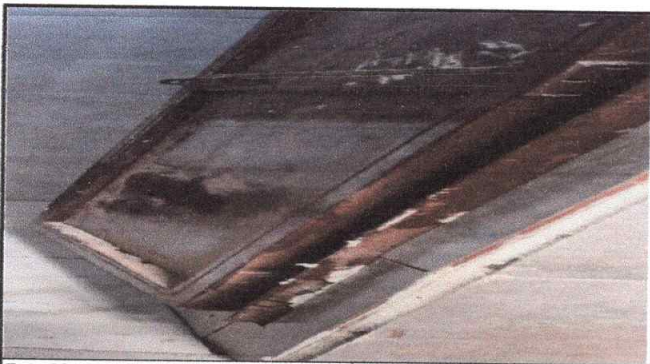
Foto 33: MANTENIMIENTO Y APLICACIÓN DE PINTURA EN PUERTAS DE BAÑO DE NIÑAS INTERIOR
