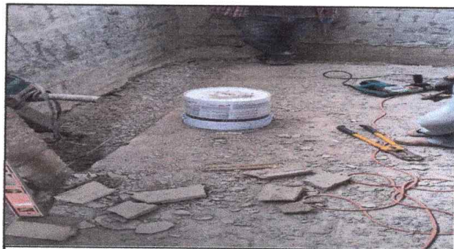
Foto 4: DEMOLICION DE MIGITORIOS
