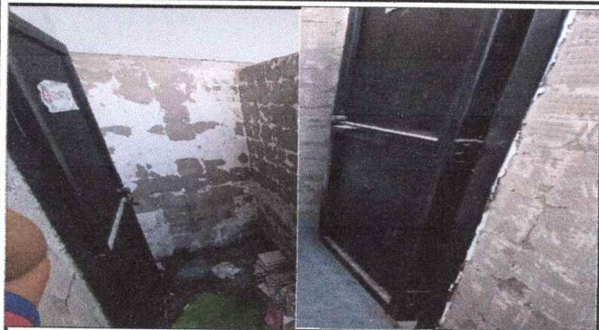
Foto 31: MANTENIMIENTO Y APLICACIÓN EN PINTURA EN PUERTAS DE BAÑO INTERIOR DE NIÑOS Y DE ENTRADA
