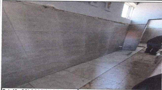
Foto 19: COLOCACION DE PISO NIÑOS
