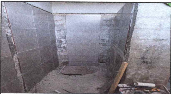
Foto 15: COLOCACION DE AZULEJO EN PARED DE BAÑOS NIÑOS
