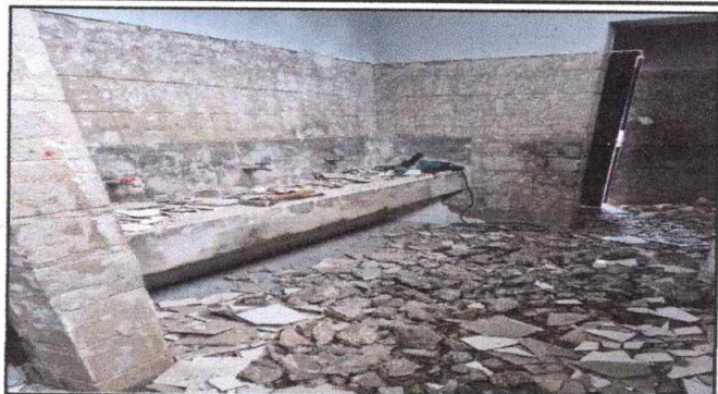
Foto 2: DEMOLICION DE AZULEJO DE LAVAMANOS DE NIÑOS
