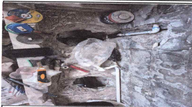
Foto 8: COLOCACION DE TUBERIA EN LAVAMANOS
