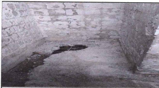
Foto 3: DEMOLICION DE PISO
