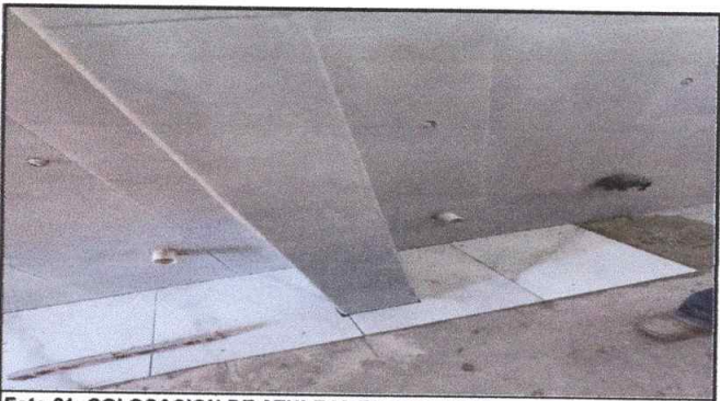
Foto 21: COLOCACION DE AZULEJO EN COLUMNA
