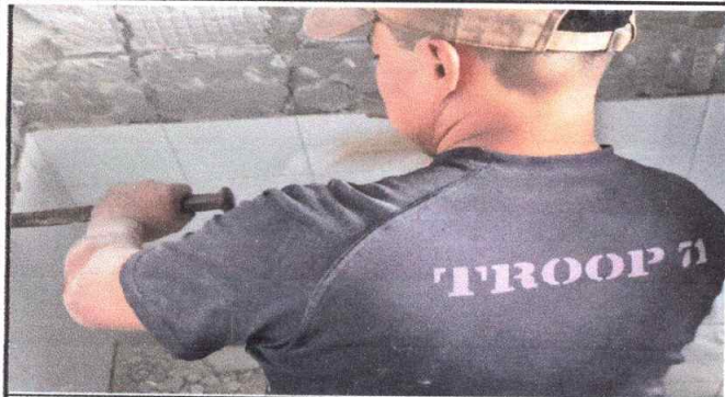
Foto1: DEMOLICION DE AZULEJO EN BAÑOS DE NIÑOS
