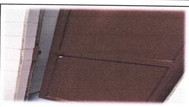
Foto 34: MANTENIMIENTO Y APLICACIÓN DE PINTURA EN PUERTAS DE BAÑO DE NIÑAS EXTERIOR
