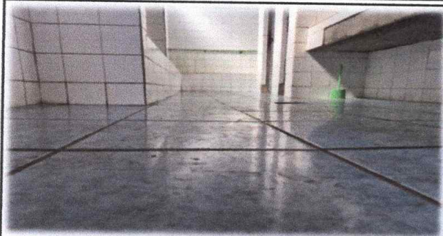
Foto 7: REMOVIMIENTO E INSTALACION PISO BAÑO DE NIÑOS A LA B
