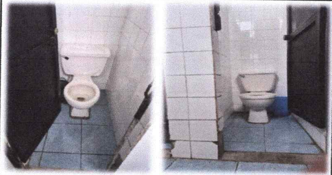
Foto 14: DESMONTADO DE SANITARIO BAÑO DE NIÑAS A LA B
