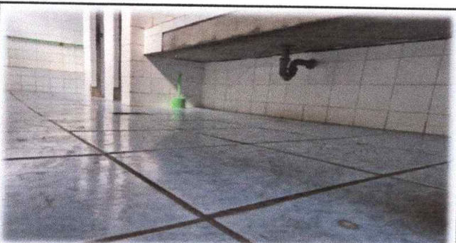
Foto 9: COLOCAION DE AZULEJO EN PILETA NIÑOS A LA B
