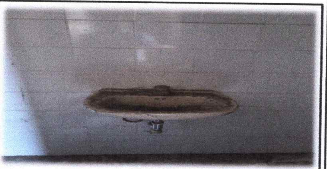
Foto 18: DESMONTAJE Y HABILITACIÓN LAVAMANOS LAVAMANOS BAÑO DE MAESTRO
