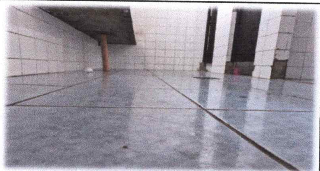
Foto 15: LEVATAMIENTO DE PISO DE AZULEJO BAÑO DE NIÑAS A LA B
