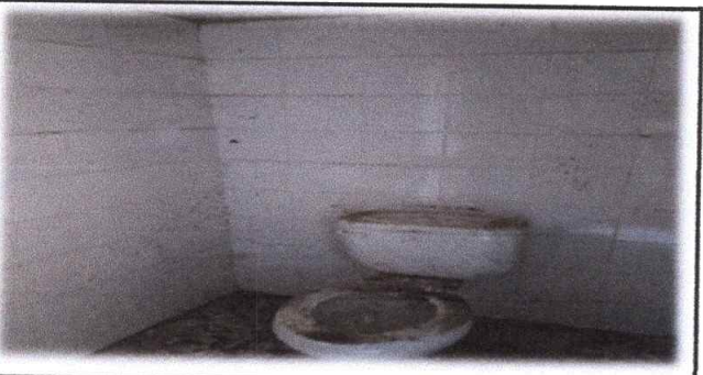
Foto 17: LEVANTAMIENTO DE BAÑO INSTALACION DE AZULEJO HABILITACIÓN DE SANITARIO BAÑO DE MAESTRO
