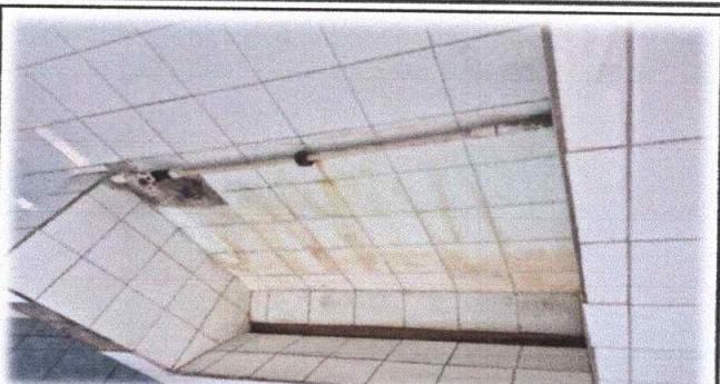
Foto 2: MIGITORIOS BAÑOS NIÑOS A LA B REEMPLAZO DE TUBERIA
