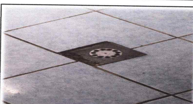
Foto 10: CAMBIO DE REPOSADERA BAÑO DE NIÑOS A LA B
