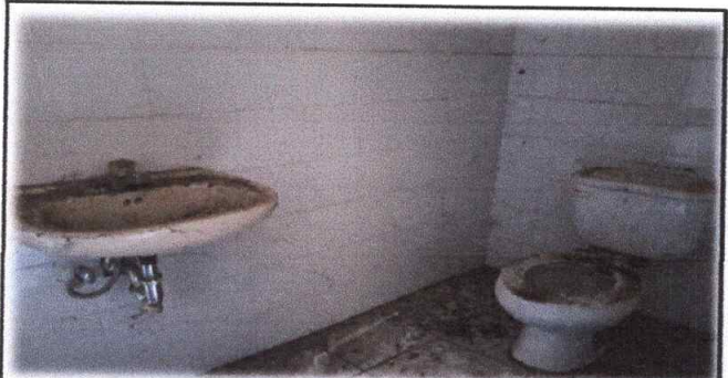
Foto 16: LEVANTAMIENTO DE BAÑO Y INSTALACION DE PISO HABILITACIÓN DE SANITARIO BAÑO DE MAESTRO
