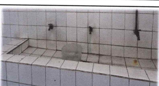
Foto 12: COLOCACION DE AZULEJO EN LAVAMANOS COLOCACION DE CHORROS Y COLOCACION DE TUBERIA DE BAÑOS NIÑAS A LA B
