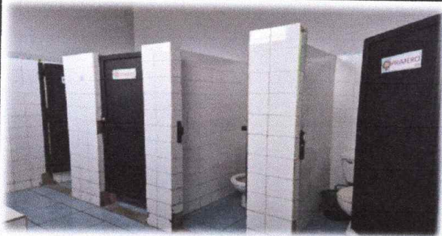
Foto 13: RESANADO LEVANTAMIENTO DE AZULEJOS, MANTENIMIENTO Y APLICACIÓN DE PINTURA PUERTAS BAÑO DE NIÑAS A LA B
