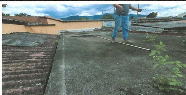
Foto 5: Terraza ubicada en el ultimo salón de la escuela donde presenta filtración de agua
