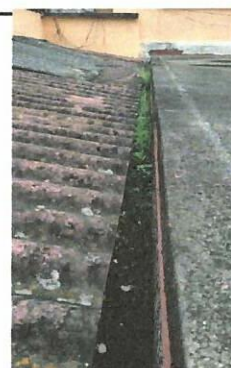
Foto 6: Canal de la terraza con obstrucción en la bajada de agua
