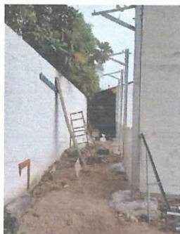
Foto 7: Fundición de contrapiso de concreto en jardín posterior de módulo de laboratorio de computación
