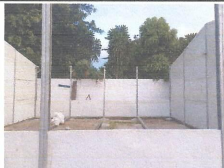
Foto 2: Módulo, suministro e instalación de unidades de iluminación
