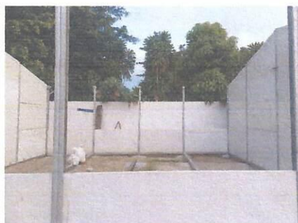
Foto 4: Módulo, suministro e instalación de estructura metálica para colocar gabinete de piso de punto central de cableado
