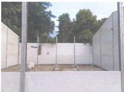
Foto 9: suministro y aplicación de pintura interior y exterior en módulo de computación y dirección
