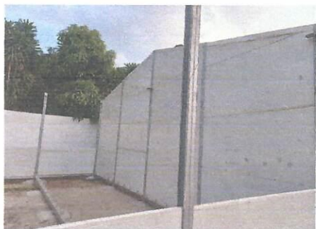
Foto 1: Módulo, suministro e instalación toma corrientes laboratorio de computación y dirección
