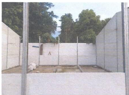
Foto 3: Módulo, suministro e instalación de red de internet para laboratorio de computación y dirección
