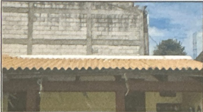
Foto 3: Vista del techo donde se han realizado trabajo de impermeabilización del techo, por la filtración que se tiene de agua.
