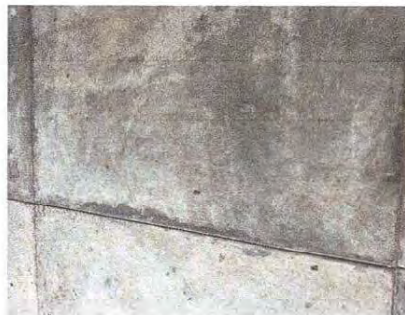
Foto 6: Se observa que no se cuenta con piso cerámico en el área de dirección.
