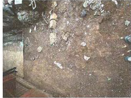
Foto 14: Se observa falta de caminamiento, por lo cual el agua entra en las aulas.
