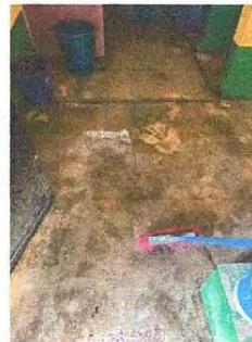
Foto 10: Se observa que no se cuenta con piso cerámico en baños.
