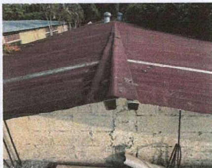
Foto 1: Se observa el mal estado de la lámina en los talleres de Electricidad (módulo No. 11)
