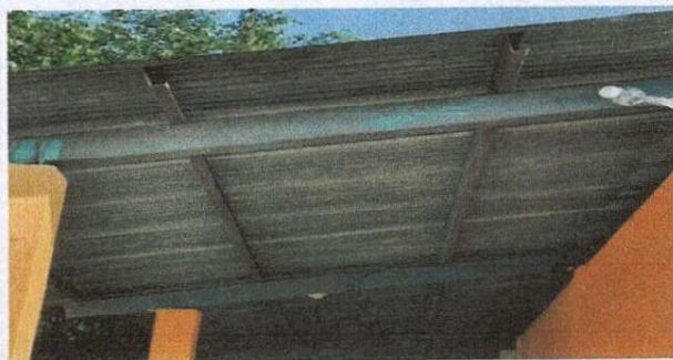
Foto 4: Se observa que la estructura de soporte de metal del módulo No. 4, necesita mantenimiento preventivo
