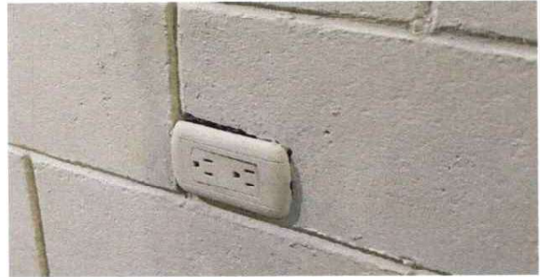
Foto 4: reparación de tomacorrientes y apagadores en aulas
