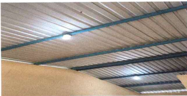
Foto 5: reparación de luminarias en sistema eléctrico en aulas
