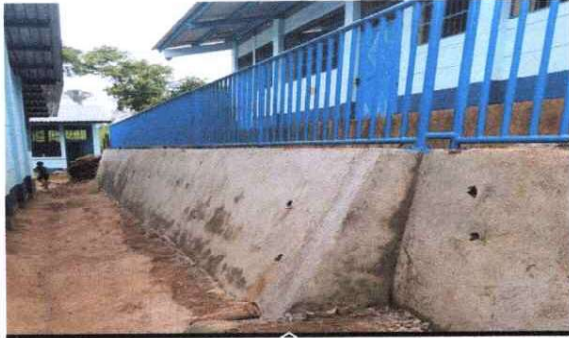
Foto 1: sustitución de muro existente por muro de concreto ciclopeo
