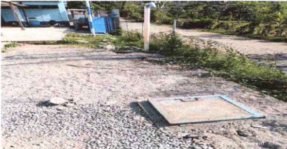
Foto 7: mantenimiento a fosa séptica.
