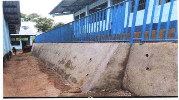
Foto 2: aplicación de sabieta en muro de concreto ciclopeo
