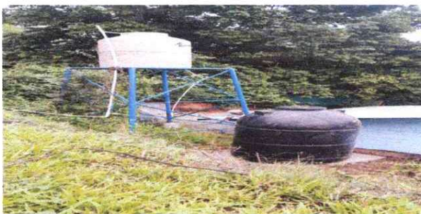
Foto 9: sustitución de deposito de agua por uno mas grande de 2500 lts.
