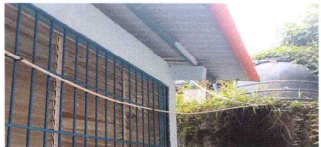
Foto 10: reparación de tubería principal
