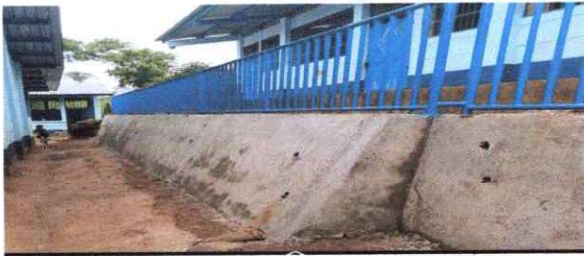
Foto 3: aplicación de repello en muro de concreto ciclopeo
