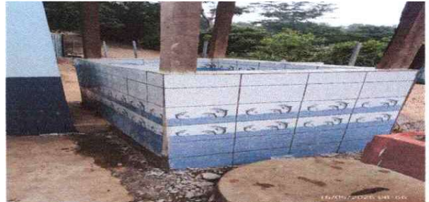
Foto 8: suministro e instalación de azulejo en pileta de patio por dentro y fuera.
