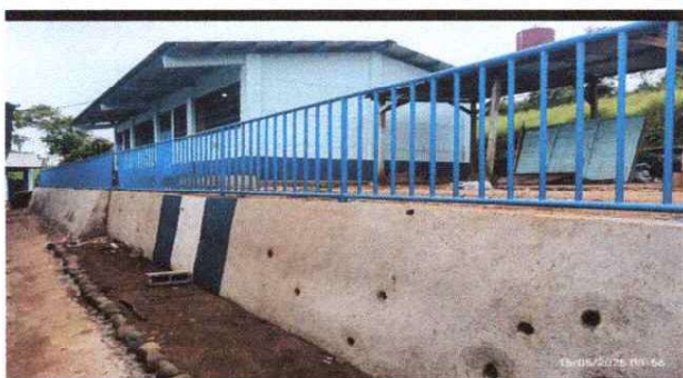
Foto 11: suministro e instalación de barandas de metal en bordes de muro de contención
