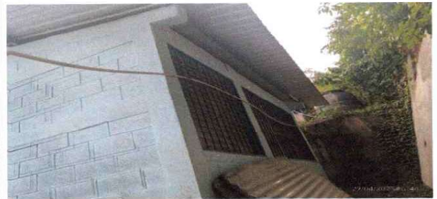
Foto 10: reparación de tubería principal
