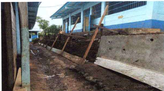
Foto 1: sustitución de muro existente por muro de concreto ciclopeo
