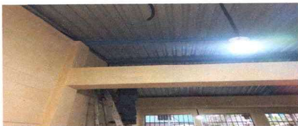
Foto 5: reparación de luminarias en sistema eléctrico en aulas
