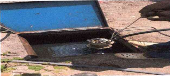
Foto 7: mantenimiento a fosa séptica.
