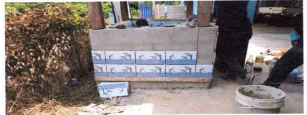
Foto 8: suministro e instalación de azulejo en pileta de patio por dentro y fuera.
