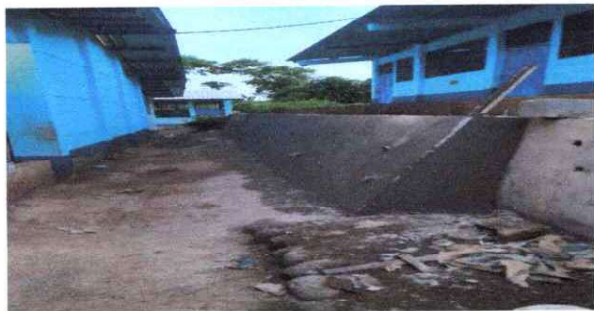
Foto 3: aplicación de repello en muro de concreto ciclopeo
