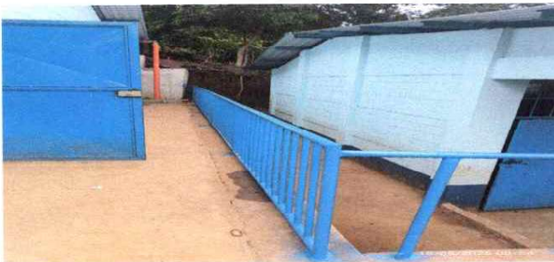
Foto 11: suministro e instalación de barandas de metal en bordes de muro de contención
