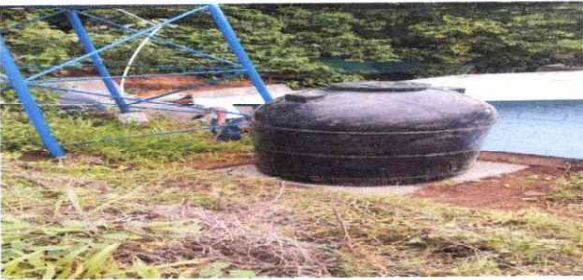
Foto 9: sustitución de deposito de agua por uno mas grande de 2500 lts.
