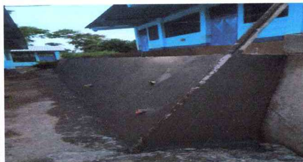
Foto 2: aplicación de sabieta en muro de concreto ciclopeo
