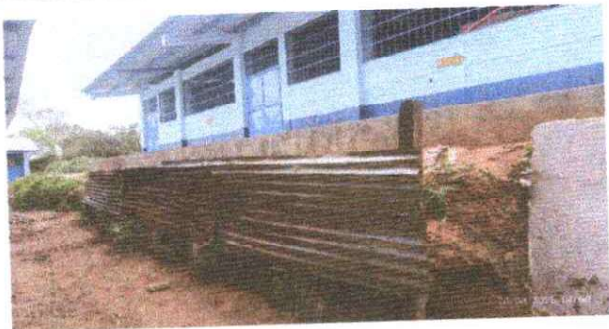
Foto 1: Se observa la necesidad de sustituir el muro existente por muro de concreto ciclopeo
