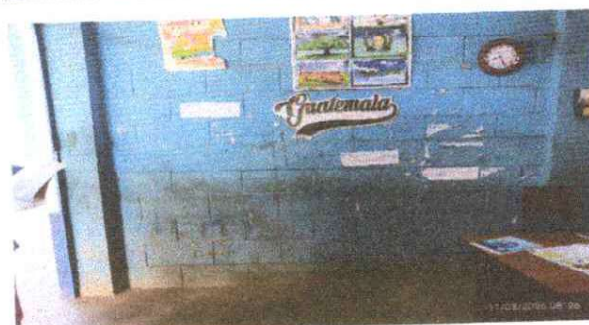
Foto 6: se observa la necesidad de aplicar pintura latex acrilica antihongos
