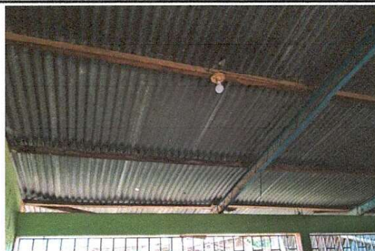
Foto 2: Se observa que la estructura de soporte de madera se encuentra en mal estado por lo que debe ser sustituida.
