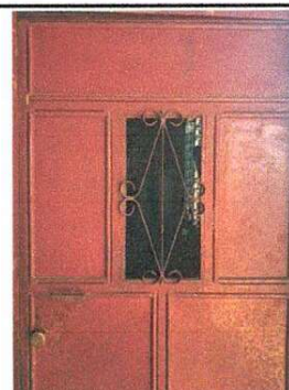
Foto 4: Se observa que las puertas cuentan con oxido por lo que requieren mantenimiento.
