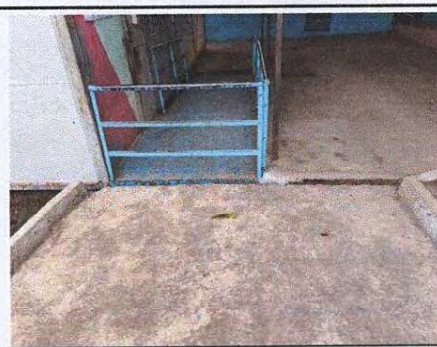
Foto 12: Se observa que el agua que viene de la pendiente del pasillo se mete al salon y para solucionar se necesita una cuneta con su regilla
