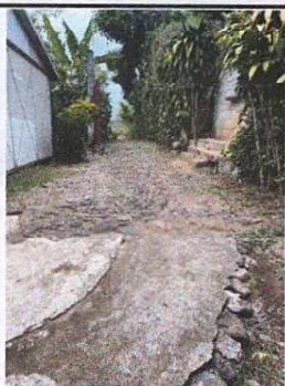
Foto 1: Se observa que la entrada de la escuela todavía es con piedra y en malas imperfecciones y a ocasionado accidentes con los estudiantes
