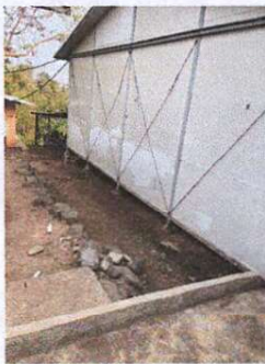
Foto 13: al momento de colocar la cuneta de concreto con su regilla necesitamos desembocar lo que recolecta la cuneta y dirigirlo hacia la tubería de la pila buscándole solución y no obstruir ni congestionar el
