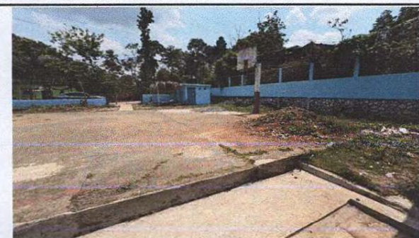
Foto 11: Se observa que las planchas de concreto requieren cambio.
