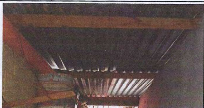
Foto 2: Se observa que la estructura de soporte es de madera, por lo que se sustituirá por soporte de metal.
