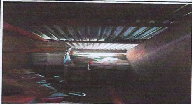
Foto 7: Se observa que no hay iluminación, por lo que se instalará sistema eléctrico.
