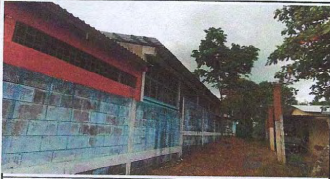
Foto 13: Se observa que el muro perimetral está demasiado bajo, por lo que se reparará con levantamiento de block, para mayor seguridad.
