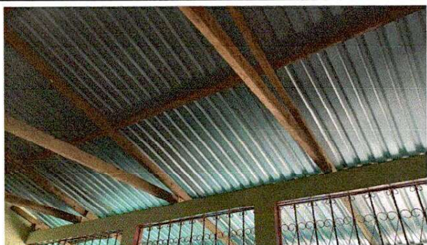
Foto 3: Se observa que la estructura de madera se encuentra deteriorada.
