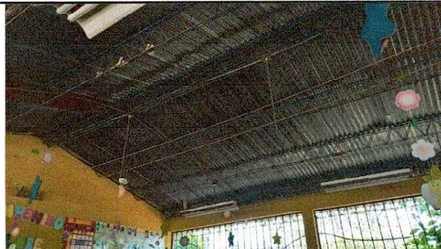
Foto 2: Se observa que la estructura de soporte de metal, necesita mantenimiento preventivo y correctivo.
