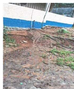
Foto 6: Se observa que necesita instalación de drenaje
