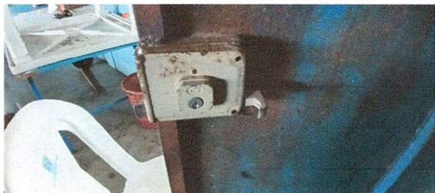
Foto 1: Se observa la necesidad de cambiar las chapas debido al mal estado
