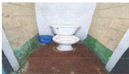
Foto 5: Se observa que el sanitario no está en condiciones aptas para el funcionamiento por lo que se debe sustituir.
