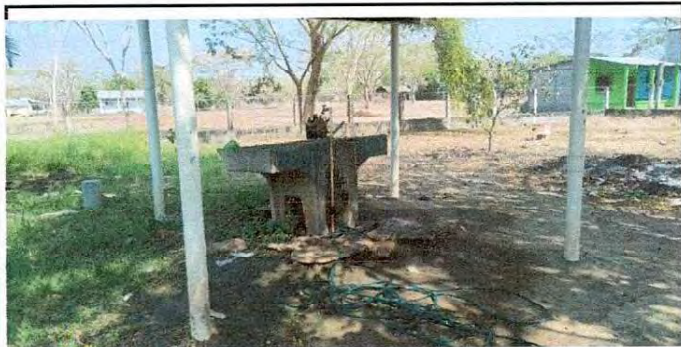
Foto 3: Reparación de la Plancha de cemento de la pila
