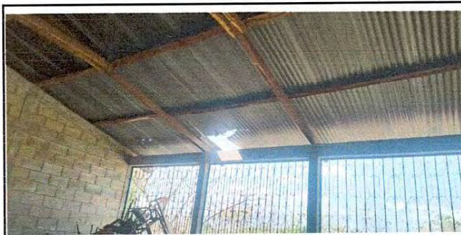
Foto 6: cambio de estructura metalica y techo del aula
