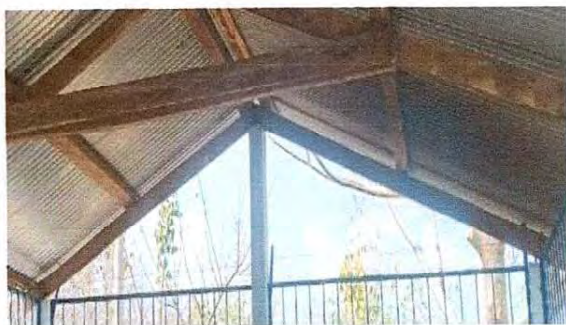
Foto 5: instalación de balcones. De ambos lados
