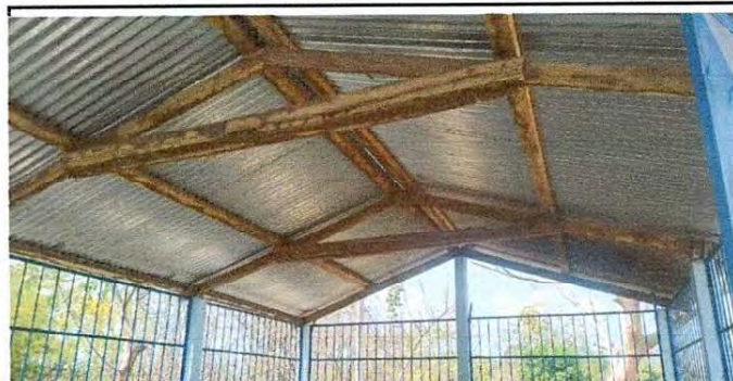
Foto 4: Sustituir estructura de madera por metal, la cocina
