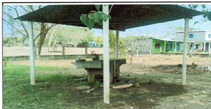
Foto 9: Tubería de línea principal, mal colocada por se va mover la pila del lugar.
