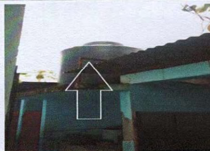
Foto 10: Se observa que el deposito de agua se encuentra en mal estado es neserio sustituirlo
