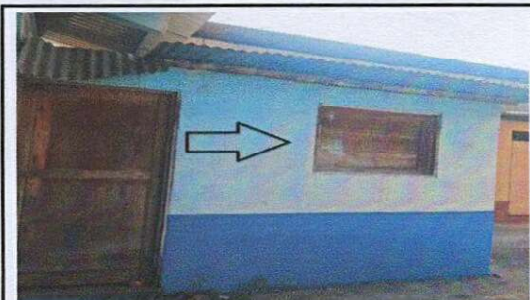
Foto 5: Se observa que la ventana de madera se encuentra en mal estado
