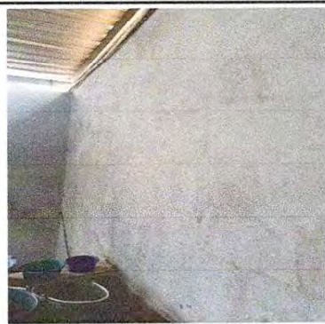
Foto 2: Se que la pared interior necesita alisado pues es repello rustico
