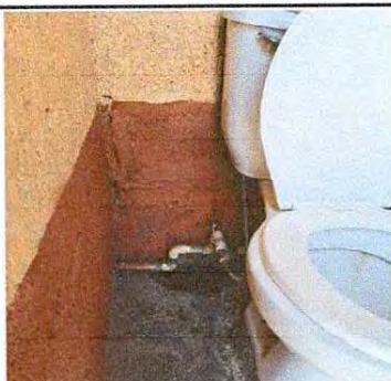
Foto 11: Se observa que se reparación de baños, accesorios e instalación hidraulica
