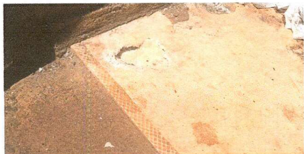
Foto 5: Se observa que la letrinas de plástico se esta rompiendo
