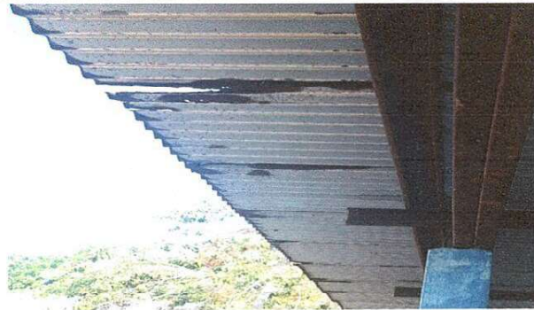
Foto 2: Se observa que la estructura de soporte de metal del módulo de aulas, necesita sustitución
