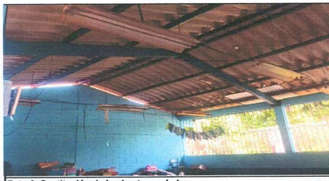
Foto 6: Sustitución de lamina troquelada
