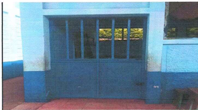
Foto 4: Sustitución de puerta en aula
