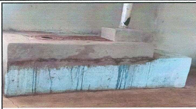
Foto 2: instalación de chimenea acero inoxidable
