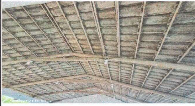
Foto 2: Se observa que la estructura de soporte de metal, necesita mantenimiento preventivo y correctivo
