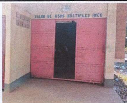
Foto 5: Se observa que el porton del salón esta deteriorado, requiere mantenimiento.
