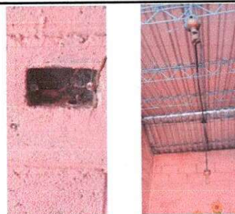
Foto 6: Se observa la necesidad de sustituir el sistema electrico debido al mal estado
