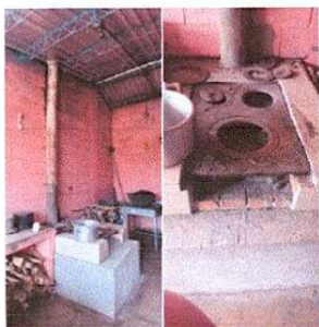
Foto 1: Se observa la necesidad de sustituir la estufa rural y colocar una chimenea debido que al cocinar se queda mucho humo que impide elaborar la alimentación
