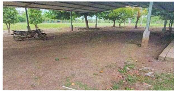
Foto 8: Se observa que es necesario el suministro de torta de concreto en salón de usos múltiples
