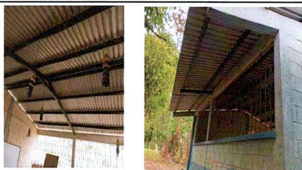
Foto 2: Se observa que la estructura portante de metal se encuentra en mal estado por lo que es necesaria su sustitución.
