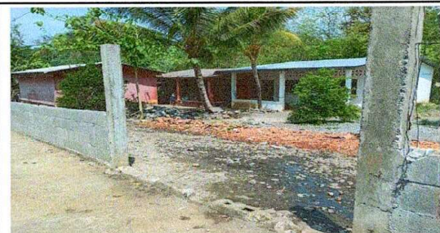
Foto 6: Se observa que es necesario el suministro y la instalación de portón de metal en la entrada principal del establecimiento.
