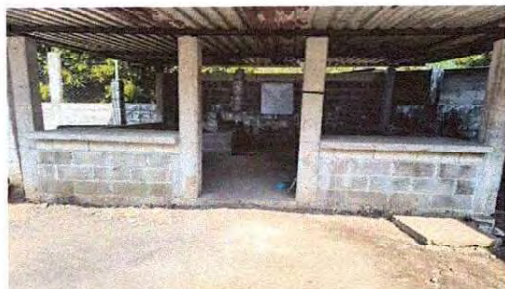
Foto 5: Se observa se necesita el suministro e instalacion de puerta para proteccion de lluvias y seguridad de la cocina.
