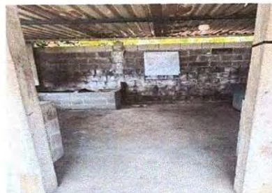
Foto 6: Se observa que es necesario el suministro e instalacion de piso ceramico.
