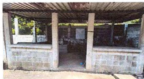
Foto 12: Se observa la estructura de la pared necesita protección de un proceso de cernido.
