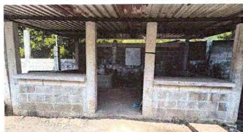
Foto 11: Se observa la estructura de la pared necesita protección de un proceso de repello.
