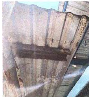
Foto 2: Se observa el deterioro de la columna por lo cual es necesario cambiar estructura de metal por metal.
