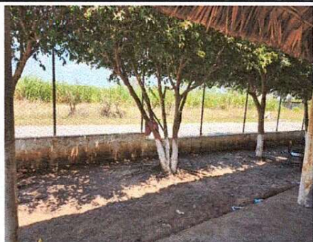
Foto 7: Se observa muros sin pintura
