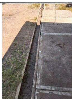
Foto 6: Urge reparación de cuneta de concreto
