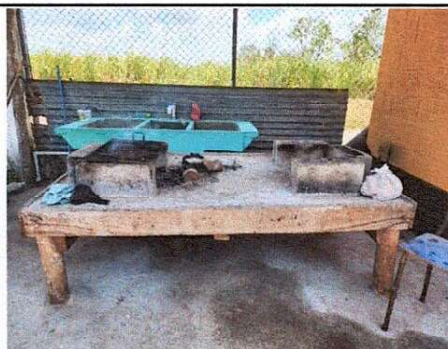
Foto 9: se observa deterioro en polleton artesanal
