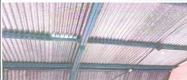
Foto 1: Se observa el mal estado de la lámina modulo 3
