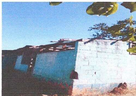
Foto 1: Sustrución de estructura de soporte de madera por metal porque se encuentra en mal estado
