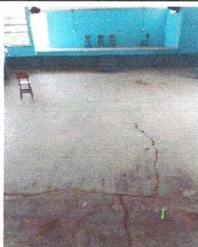
Foto 9: suministro e instalacion de piso ceramico
