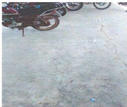
Foto 8: suministro e instalacion de piso ceramico
