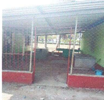
Foto 2: suministro e instalacion de balcon de metal.
