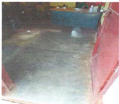
Foto 7: suministro e instalacion de piso ceramico
