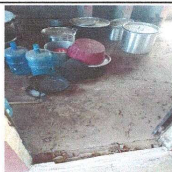
Foto 4: Suministro e instalacion de piso ceramico
