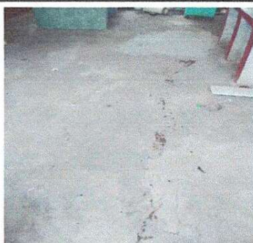
Foto 5: auministro e instalacion de piso ceramico
