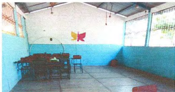
Foto 15: Resane y aplicación de pintura latex acrílica en muros exteriores e interiores Modulo V
