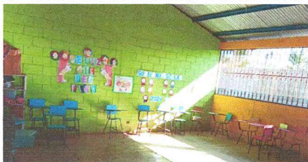
Foto 5: Se observa que las aulas es necesario el resane y aplicación de pintura latex acrílica en muros exteriores e interiores
