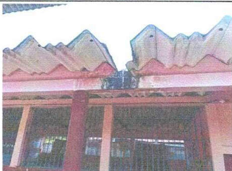
Foto 1: Se observa el mal estado de la lámina duralita.
