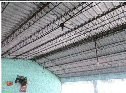
Foto 3: Se observa que la estructura de soporte de metal, necesita sustitución.
