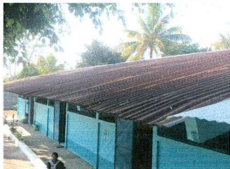
Foto 1: Se observa el mal estado de la lámina del módulo 1
