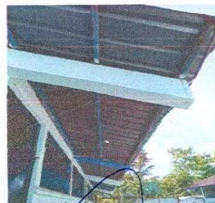
Foto 6: Se observa que es necesario proteger el aula de filtración de agua por lo que se necesita sustitución de lamina y canal de bajada de agua.
