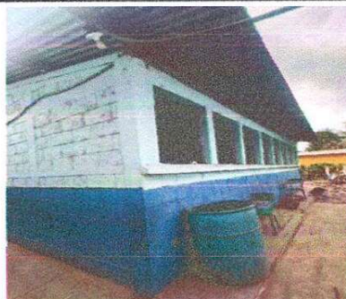
Foto 10: Se visualiza que la lámina necesita sustitución de lámina por lámina.
