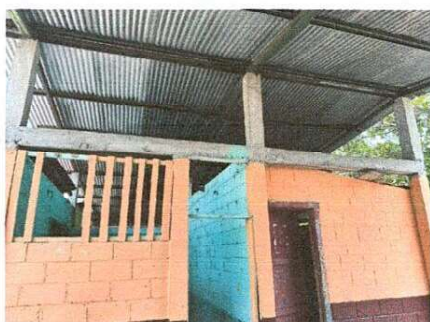
Foto 3: Sustitución de barandas de madera, a barandas de metal
