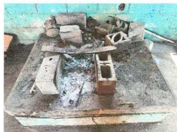
Foto 4: Se observa la necesidad de cambiar Suministro de estufa rural de 60x2 metros incluye chimenea de acero inoxidable AISI
