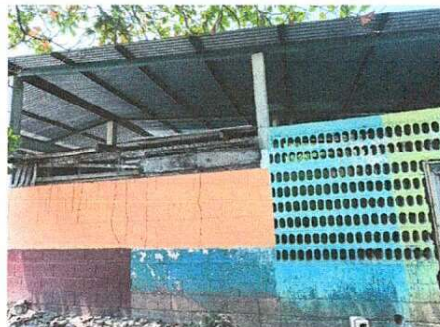
Foto 2: Sustitución de estructura de soporte de metal
