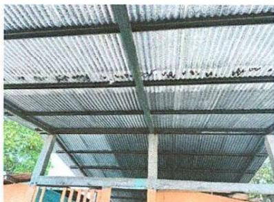
Foto 1: Se observa la necesidad de cambiar la lámina, ya que se encuentra en mal estado
