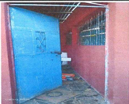
Foto 7: Mantenimiento a Puerta de Cocina
