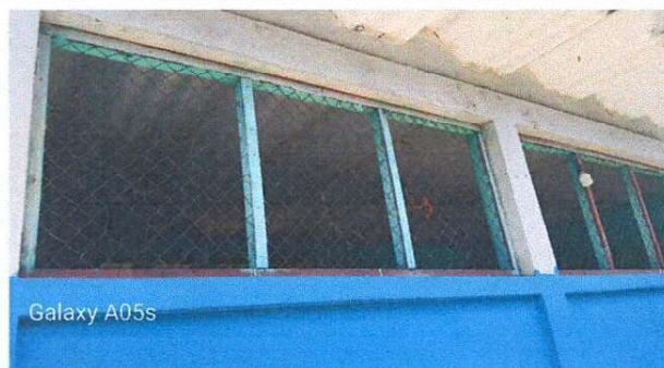
Foto 2: sustitución de balcones a metal
