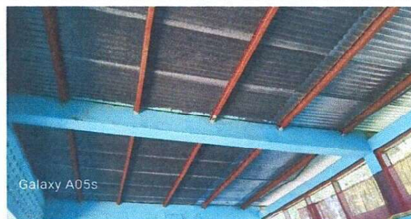
Foto 4: Sustitución de lámina y estructura metálica
