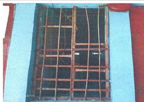
Foto 6: Sustitución de Balcón de metal de Bodega de cocina.
