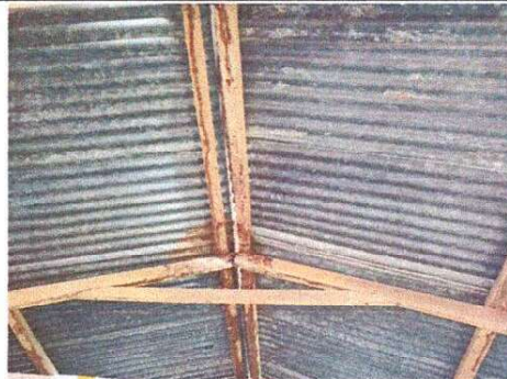
Foto 2: Se observa que la estructura de soporte de madera, necesita mantenimiento preventivo y correctivo
