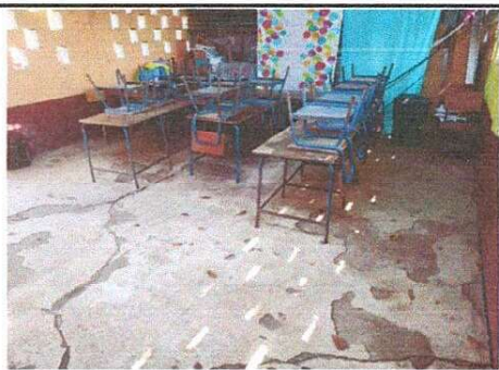
Foto 5: Se observa el piso de salone de clases en mal estado con grietas y agujeros.
