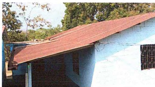
Foto 6: Se observa que la lámina galvanizada se encuentra en mal estado. Por lo que se necesita cambio.
