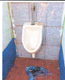
Foto 12: Se observa que los migitorio tiene los accesorios en mal estado por lo que es necesaria la reparación.
