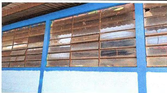
Foto 5: Se observa que las ventanas de vidrio se encuentran en mal estado por lo que es necesario la sustitución de balcones de metal.
