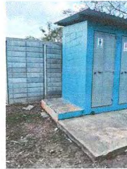
Foto 2: Se observa que los baños, no cuenta con lavados.
