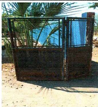
Foto 7: Se observa que el portón de la entrada principal se encuentra en mal estado por lo que es necesaria su sustitución.
