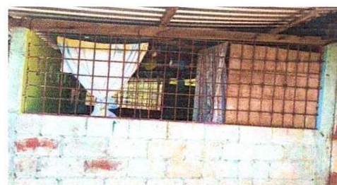
Foto 6: Se observa que la estructura de metal de los balcones se encuentran en mal estado por lo que es necesaria su sustitución.
