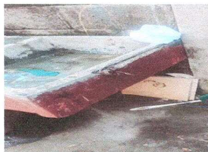
Foto 8: La sustitucion de la pila es importante, ya que posee alambres que pueden perjudicar a los niños. En la fotografia se puede observar el deterioro de la misma.
