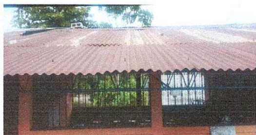
Foto 1: Se observa el mal estado de las laminas del aula en el modulo
