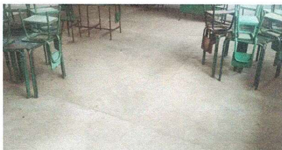
Foto 5: Actualmente es el aula de nivel inicial el cual posee piso de torta, se sustituirá por piso cerámico.
