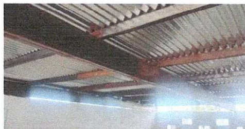
Foto 2: Se observa que la estructura de soporte de metal, necesita mantenimiento preventivo y correctivo, empieza a oxidarse.
