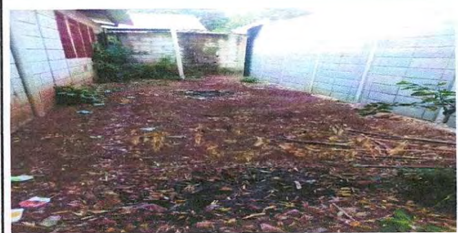
FOTO 22: Se observa que es necesario el suministro e instalación de línea principal de agua potable.
