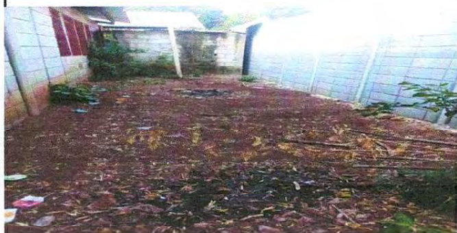
FOTO 25: Se observa que es necesario el suministro y la instalación de torre para depósito de agua. Así mismo el suministro del depósito de agua de 1100 lts correspondiente.
