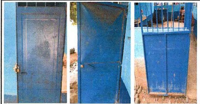
Foto 2: Se observa que las puertas de los módulos de aulas y baños requieren mantenimiento con pintura anticorrosisva.
