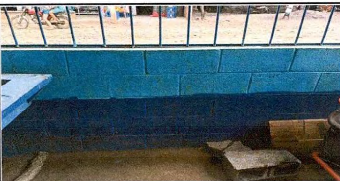
Foto 11: Se observa que es necesaria la aplicación de repello en paredes de cocina.
