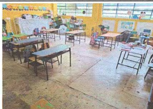
Foto 4: Se observa piso de concreto rustico en aulas
