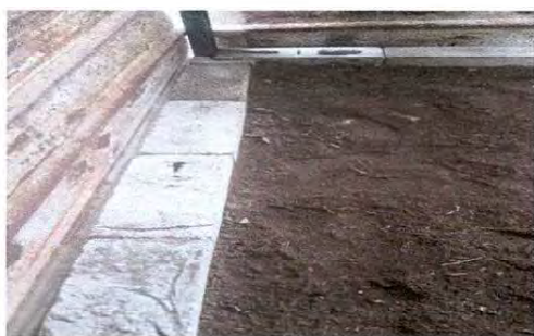
Foto 5: Se observa que no se cuenta con piso de cemento en la cocina.
